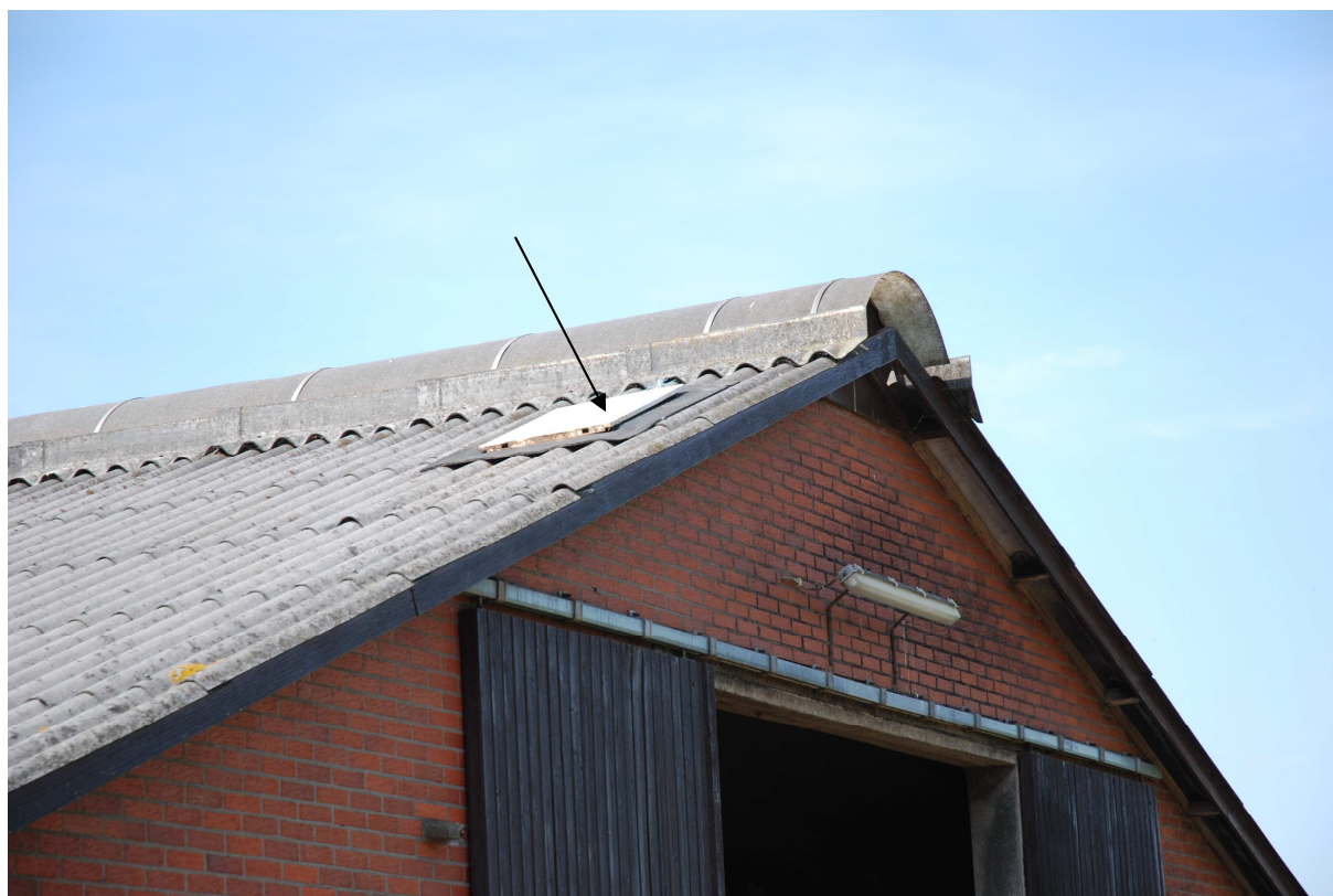
Het nest bevond zich onder de golfplaten (pijl). De boer heeft nog een poging ondernomen de zonnearmte wat te tegen te houden door een deel van het dak af te dekken (foto: R. van Harxen)
