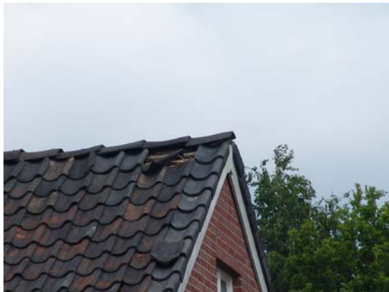
Foto 4. Vershoven dakpannen in 2005
